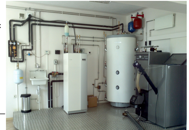
Типова схема підключення геотермального теплонасосу в парі з твердопаливним котлом
